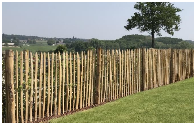
Ganivelles + poteaux bois et fils métalliques
