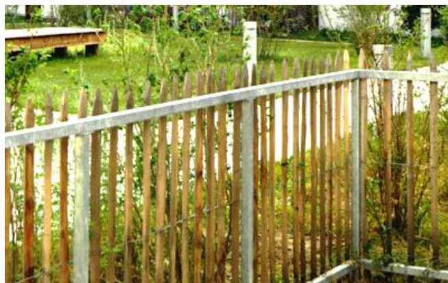
Ganivelles + structure métallique
