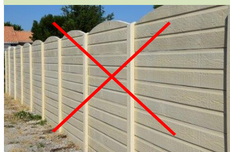
Panneaux béton préfabriqués
