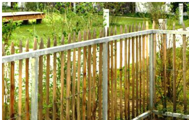
Ganivelles + structure métallique
